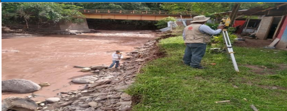
FOTOGRAFÍA N°01: EROSION DE LA RIBERA QUE AFECTA A CARRETERA
